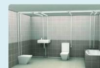
Instalación de fontanería con tubería multicapa de polipropileno reticulado. Red de bajantes y colectores de saneamiento de pvc aisladas acústicamente, para garantizar un elevado confort.
