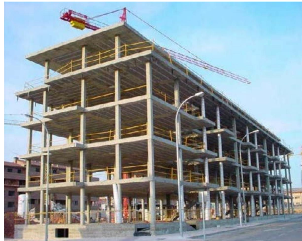
La estructura se realizará con columnas y forjados de hormigón armado, todo conforme a la legislación vigente.
